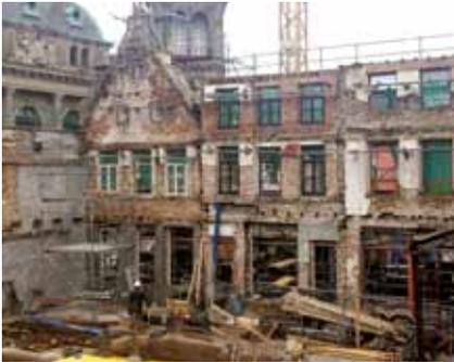
Februar 2014: Die historischen Fassaden wurden während der Bauzeit gesichert, abgestützt und anschließend saniert (rückwärtige Ansicht).
